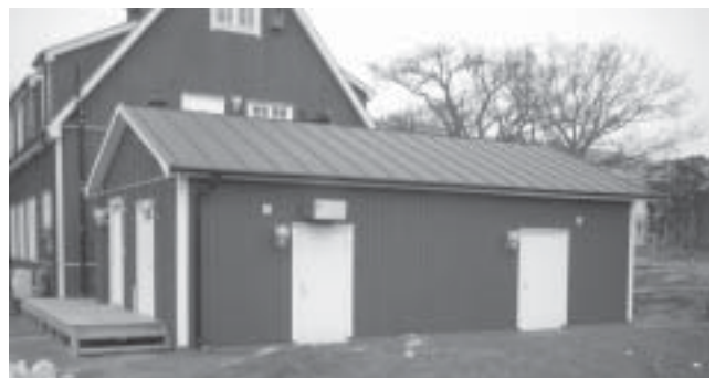
Nytt servicehus vid gamla marketenteriet
