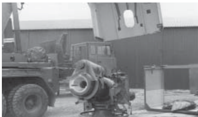
En trotjänarens sista färd. Bild från nedmonteringen 1982
