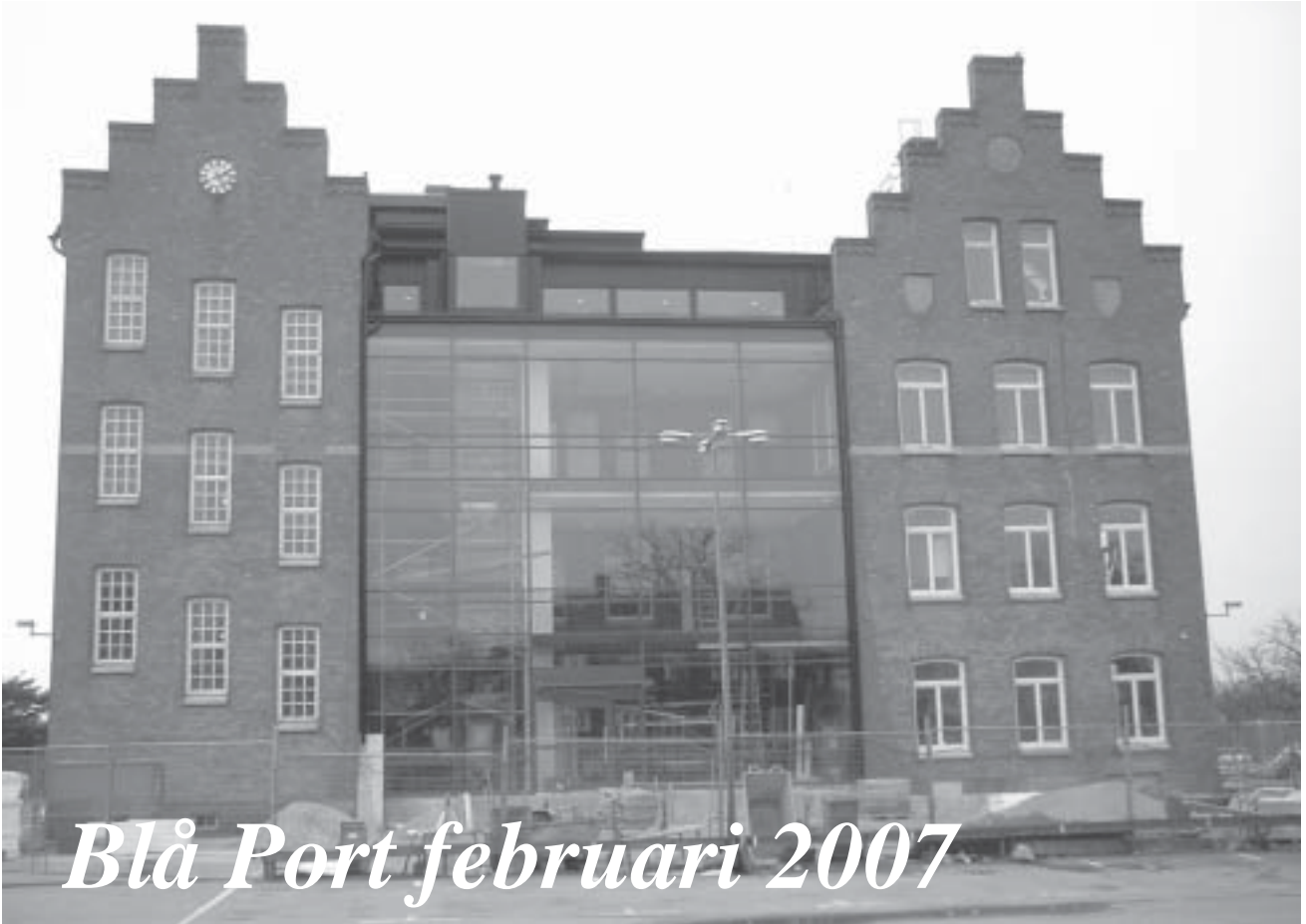
Huvudbyggnaden har åt gårdssidan inglasats och utrustats med bl.a. hiss.
